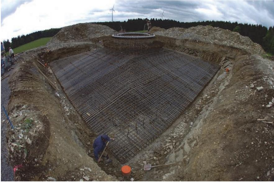
Abb. I. 8: Erdaushub und Fundamentbewehrung
